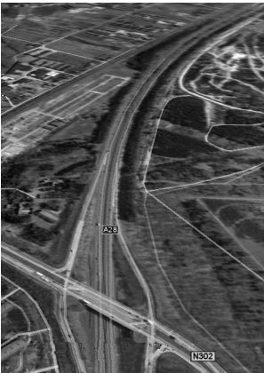
De bocht in de A28 na het viaduct Harderwijk richting Nunspeet
